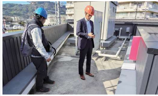
屋根上調査(兵庫県/カーディーラー)
