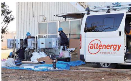
自社対応の発電所保守作業(群馬県/部品メーカー)
