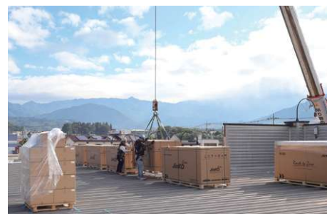
太陽光パネルの屋根上揚重(山梨県/スーパー)
