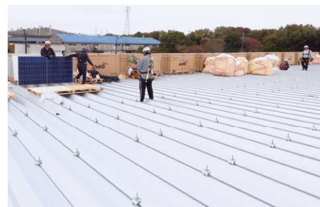
太陽光パネル設置前の屋根(三重県/部品メーカー)
