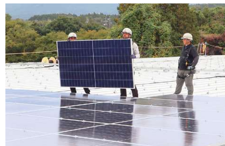
太陽光パネルの設置(三重県/部品メーカー)
