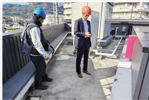
屋根上調査(兵庫県/カーディーラー)
